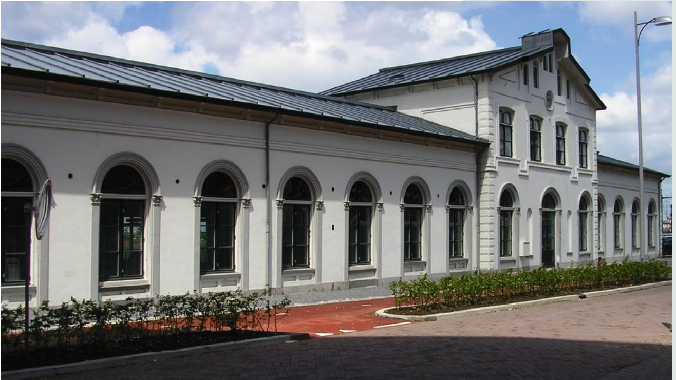
Oude stationsgebouw Amersfoort
