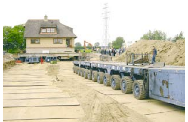
Voorbeeld van een vergelijkbaar project: een woonhuis op wielen!
